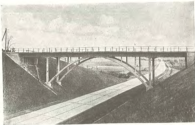
Fig. 13. Vejbane af Jernbeton.
